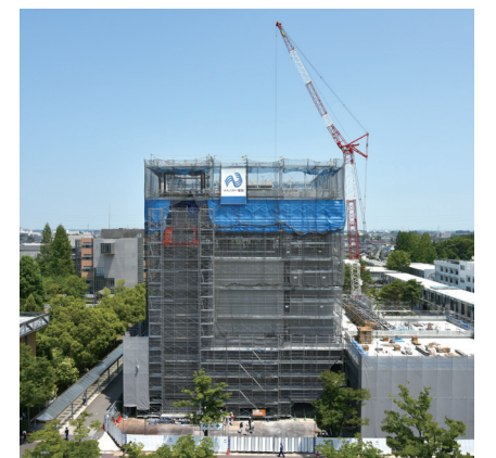
建設中の講義棟
