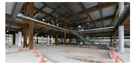
建設中の学生プラザ
